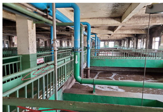
污水处理站现状
